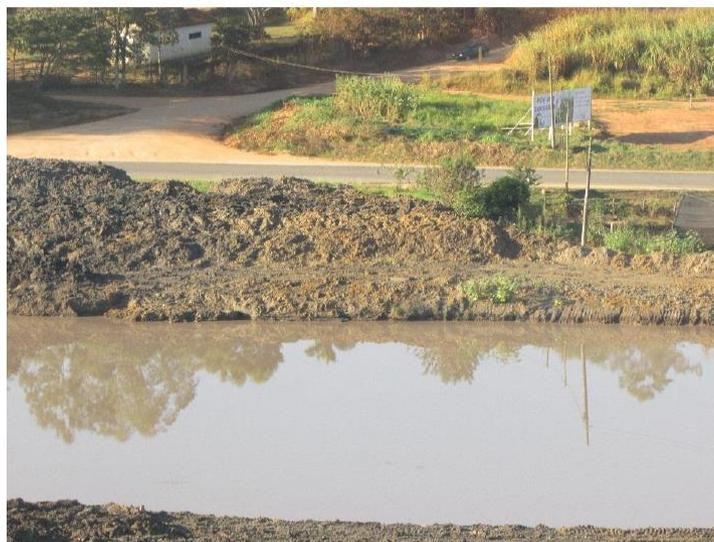
Figura 01- Transbordamento de águas pluviais pela ausência de sistema de vazão após represamento (Foto do Autor: 27/05/2018)
